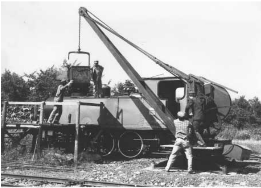
Chargement du charbon avec une grue et une berline à Sentheim: le treuil est à bras pour monter 500 kg de charbon dans la soute!
